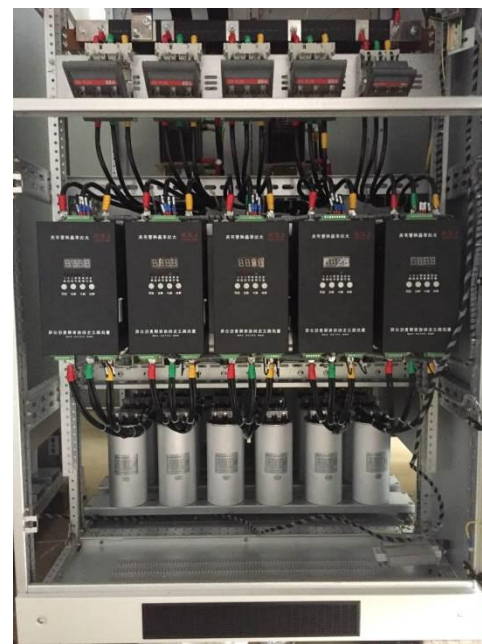
晶闸管+滤波电容器 (525V)
