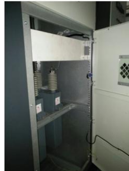
绝缘挡板 (防止熔断器弹出造成短路)
